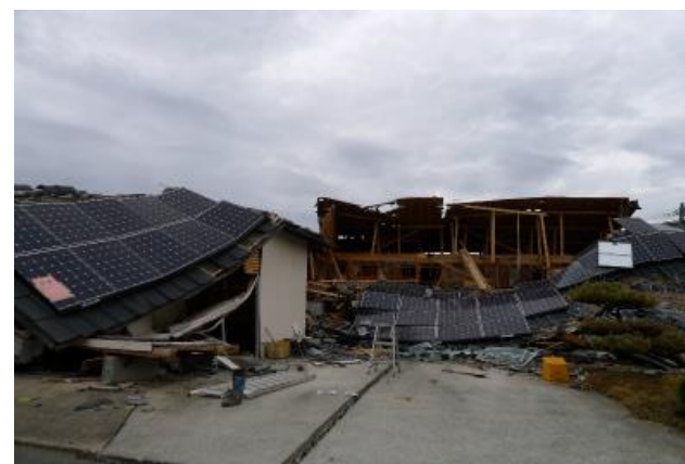
(d) 水平構面の破壊
