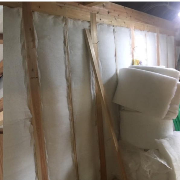
壁～パーフェクトバリア (ア)100 +フェノバボード(ア)30
