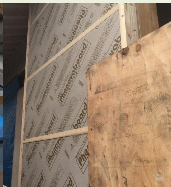
壁～パーフェクトバリア (ア)100 +フェノバボード(ア)30
