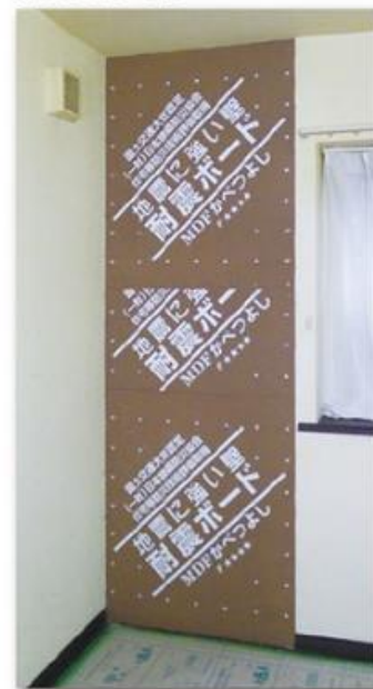
面材(MDF・モイス)を施工
