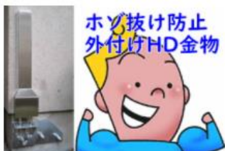
後付けホールダウン金物 いのちまもる
