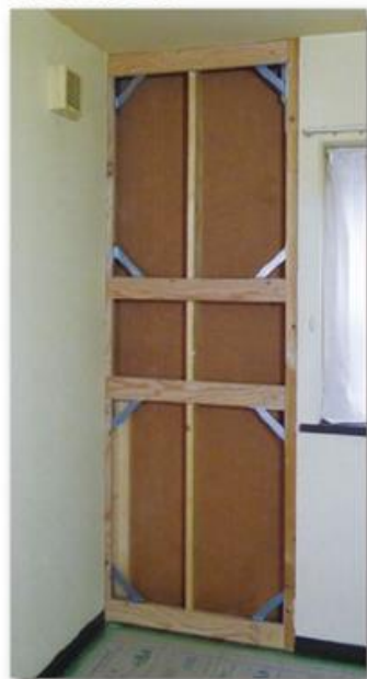
接合金物・横桟等を施工
