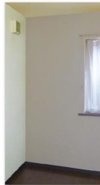
クロスを貼って仕上げ
