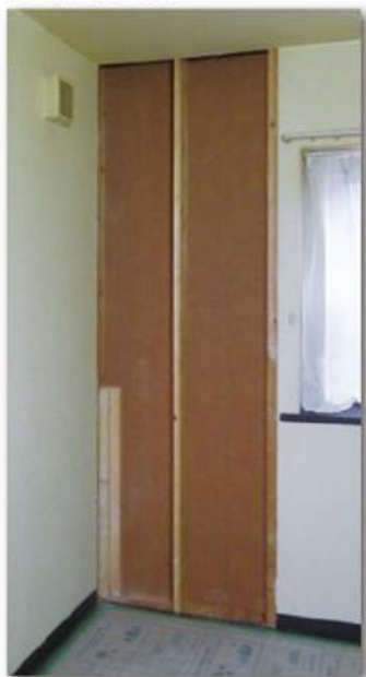
クロス・ボードを解体
