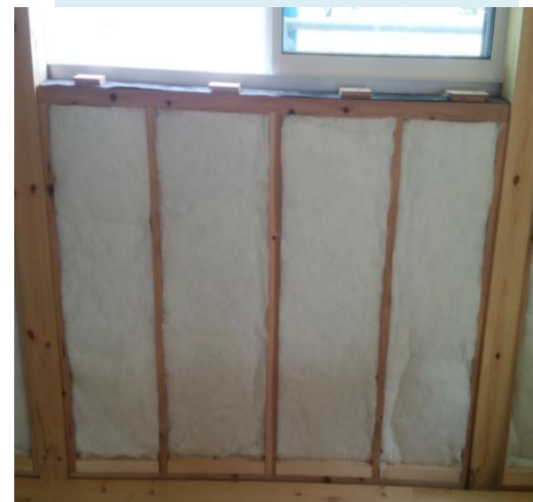
アクリアールでの施工写真
