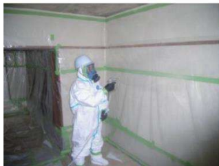
隔離・養生シートへの粉じん飛散防止剤の散布
