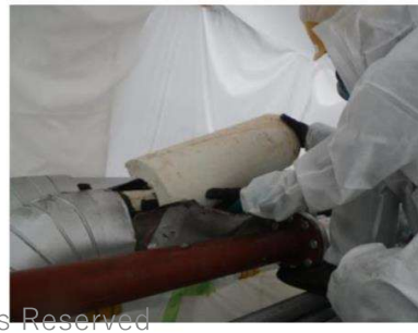
作業の状況(養生内で湿潤化後手作業で除去)
