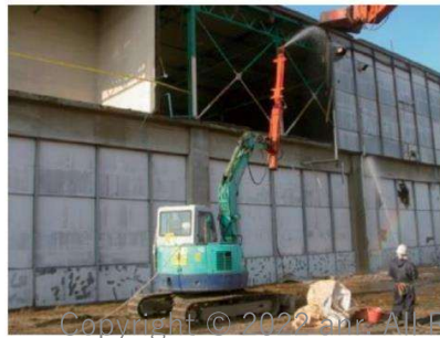
湿潤化の例(散水)
