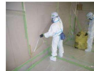
養生シートの撤去
